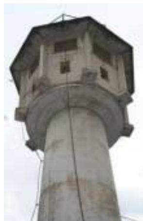
Das blieb von der Grenzanlage übrig: ein Wachturm, von dem aus Soldaten die Grenze überwachten.
